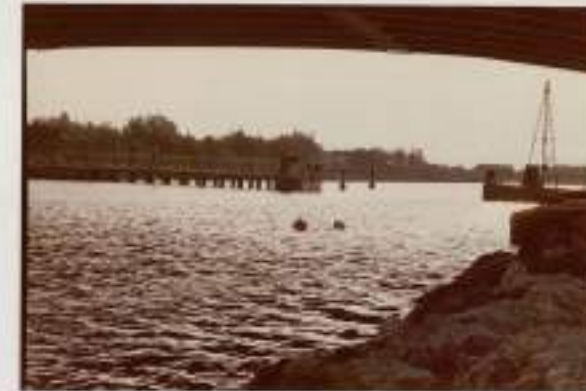
VUE DES BOUES MATERIALISANT L'EMPLACEMENT DU COURANTOMETRE, SOUS LE PONT FACE A LA "PASSE-POISSONS"
